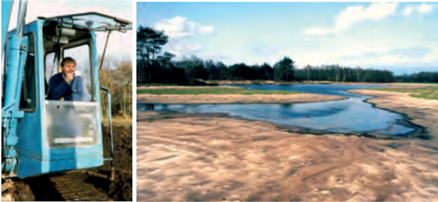
Abb. 14: An der Westseite des NSG Stroothuizen wurde in 1993/'94 ein Maisacker abgegraben, wobei das frühere Relief sorgfältig wiedergebracht wurde (Fotos A.J.M. Jansen).
